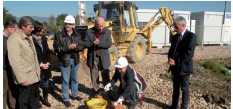
Inaugurazione dei lavori, ottobre 2010.
